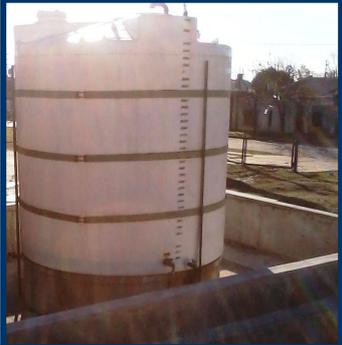
2. A continuación se inyecta el coagulante. El que se utiliza actualmente es el Sulfato de Aluminio líquido 7.6% que se almacena en tanques plásticos y es bombeado e inyectado en el caño de entrada del agua cruda previo a su ingreso a la cámara de carga. Es importante mencionar que la planta está preparada para operar con otros productos como el policloruro de aluminio (PAC) y el sulfato de aluminio sólido.
