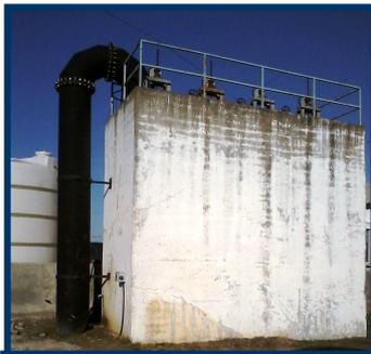
1. En la planta, el agua ingresa a través de una cañería a la cámara de carga, previa dosificación del coagulante, se produce una mezcla hidráulica y de allí se distribuye hacia los tres floculadores. Previo a la elevación a la cámara de carga, se encuentra emplazado un caudalímetro electromagnético con un sensor, cuya lectura se transmite a un computador o monitor Terminal ubicado en la planta.
